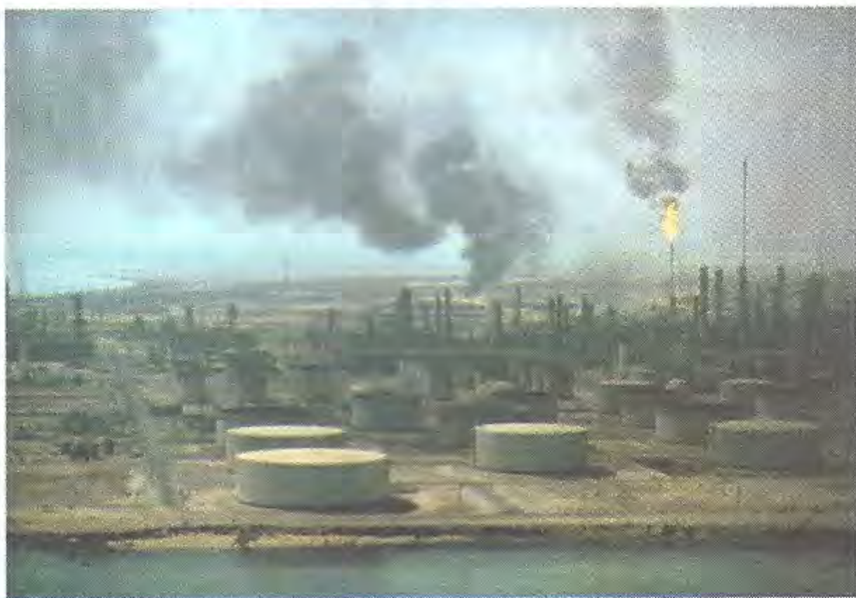
Нефтеперегонные заводы в Саудовской Аравии
